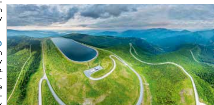
Přečerpávací vodní elektrárna Dlouhé stráně
